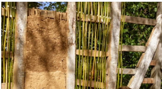
Fabrication d'un mur en torchis à base d'osier
